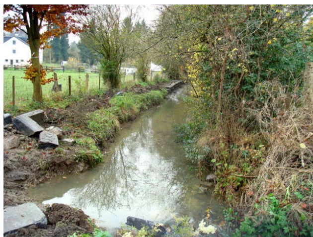
Vue de puis le Point C, vers le sud. (chemin réparé en partie).
