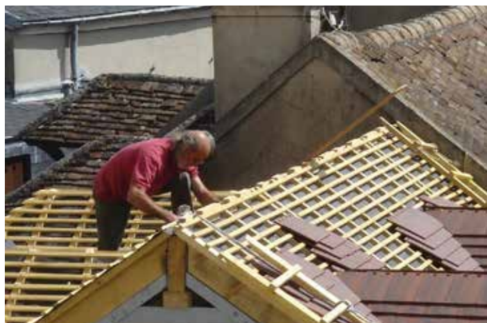
Rénovation de toiture
