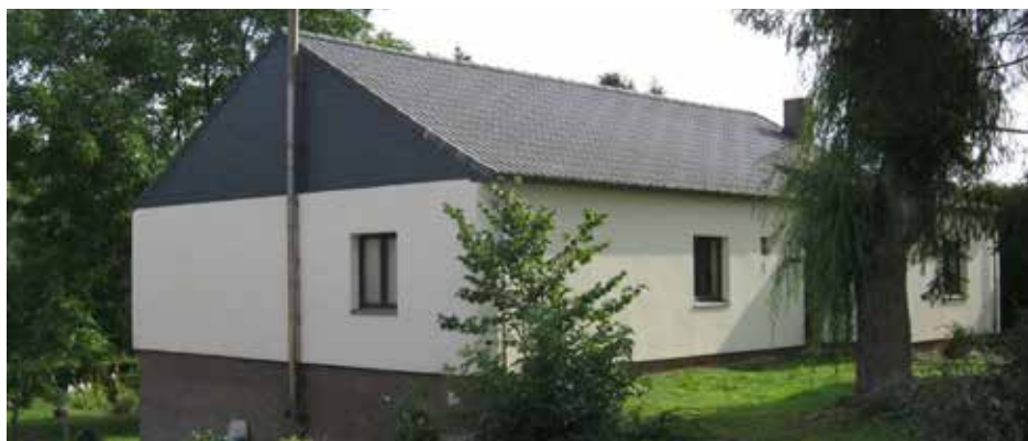
Isolation des murs par l'extérieur (Liège expansé en 14 cm sur 150 m 2 + crépi)
